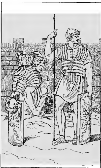
CASTRÀ MURO FOSSAQVE MUNIUNTUR
